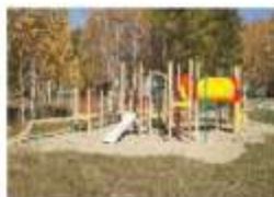
Обустройство детской спортивной площадки
